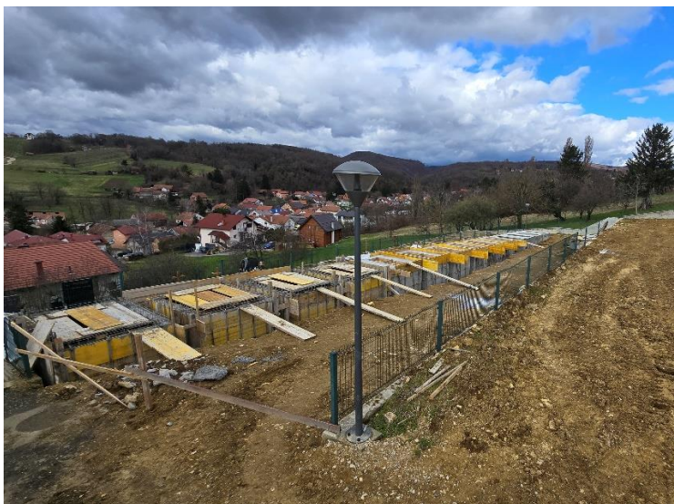
Slika 6. Izgradnja grobnica na gradskom groblju Sveti Ivan Zelina
